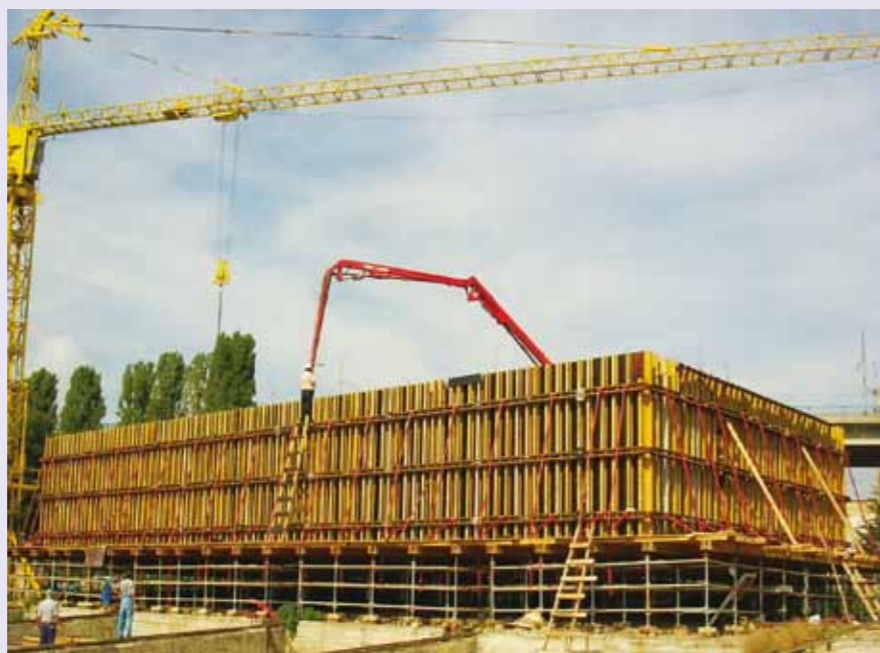
Полагане на бетон
