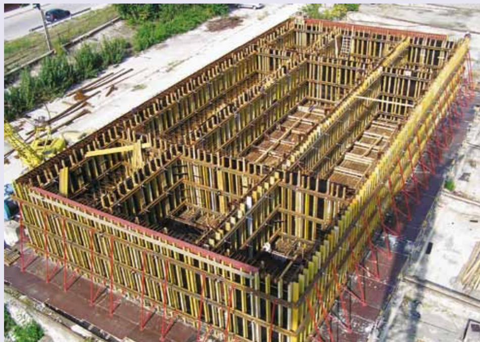
Етап от изграждане на кофража за понтона на стапела на северния хелинг на „Корабно машиностроене“ АД
